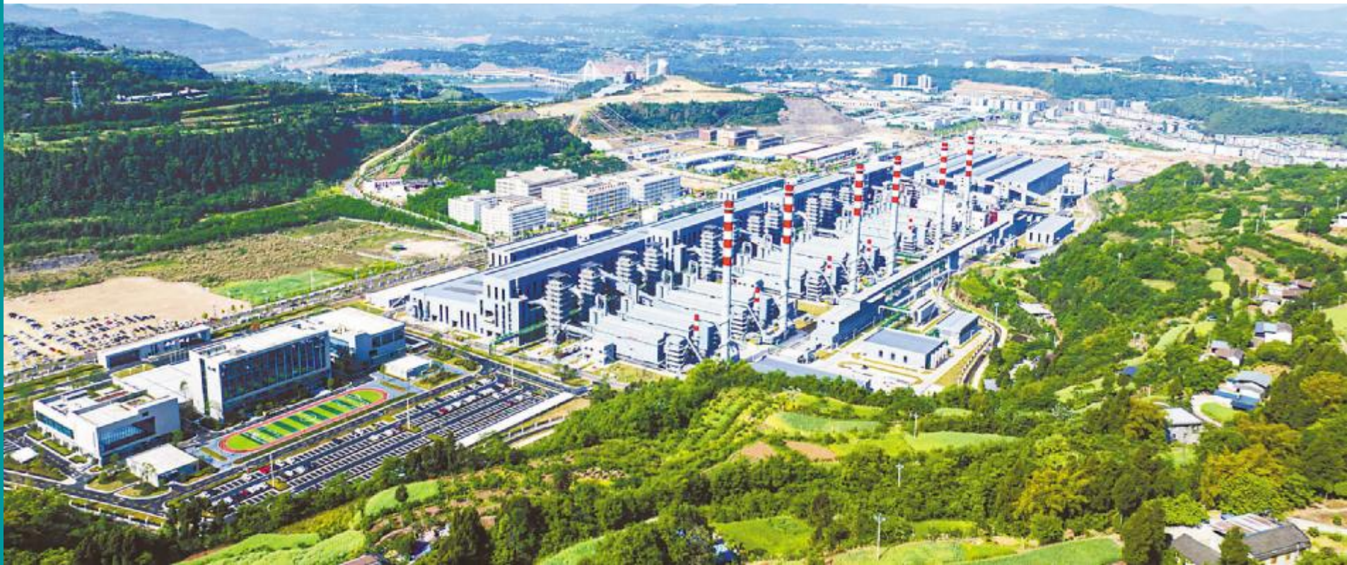
通威绿材(广元)厂区
